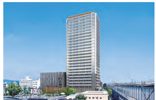
JR前橋駅北口地区市街地再開発事業(前橋市)
