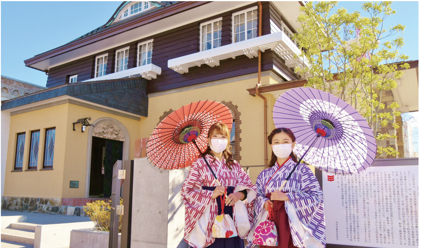
沼田市旧土岐家住宅洋館
