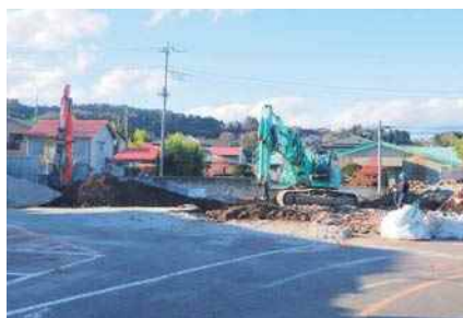
解体作業が進む役場旧庁舎跡地
