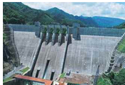
八ツ場ダム(下流側より)
