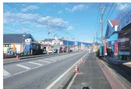
区画整理を行ったJR群馬原町駅北側
