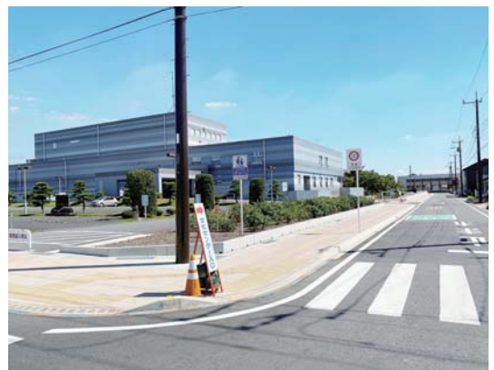
インターロッキングブロック舗装
