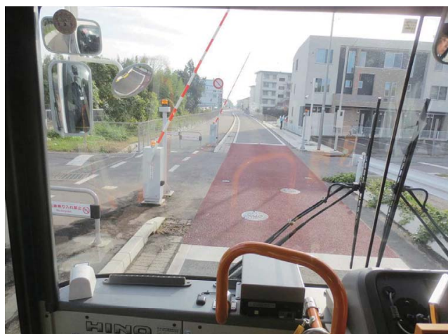
鉄道跡地を利用したBRT専用道
