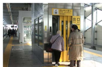
【エレベーターの設置】
