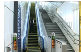
【エスカレーターの設置】
