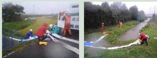
排水ポンプ車出動状況
