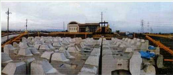
H8年度 広瀬川防災ステーション整備 土砂V=7,000m 3 、碎石・栗石V=60m 3 根固めブロック120個、植栽1式
