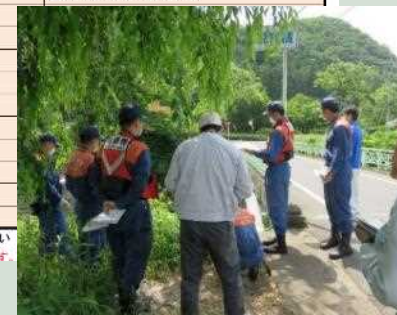
点検結果例(桐生土木事務所)
