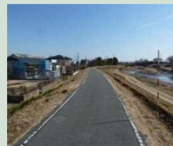
堤防天端舗装状況(烏川)
