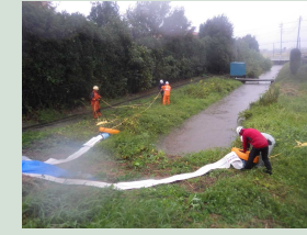
排水ポンプ車出動状況
