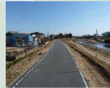
堤防天端舗装状況(烏川)
