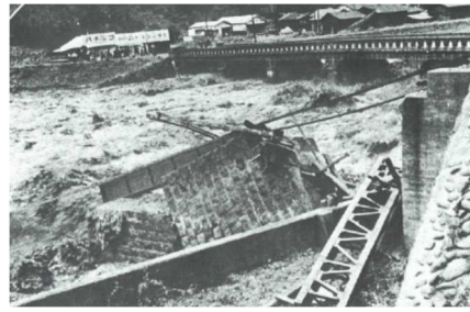
図 2.2 伊勢湾台風による災害状況 (草軽電気鉄道橋梁の流出、吾妻川)
