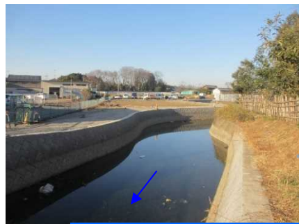
河川拡幅後(中流1工区)
