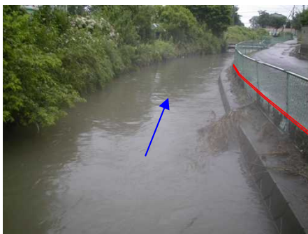
整備前(平成14年7月)
