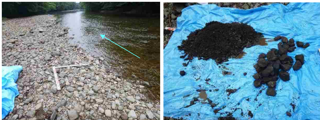
調査状況写真 (中木ダム)
