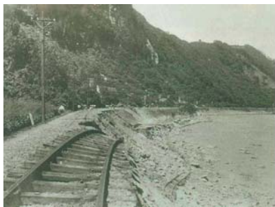
図 2. 2 カスリーン台風による災害状況（国道 17 号線、上越線の崩壊）
