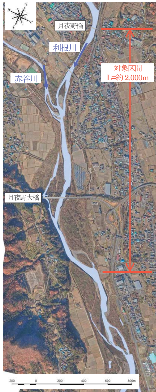
図4.17 航空写真 (利根川：⑤月夜野大橋下流～月夜野橋)
