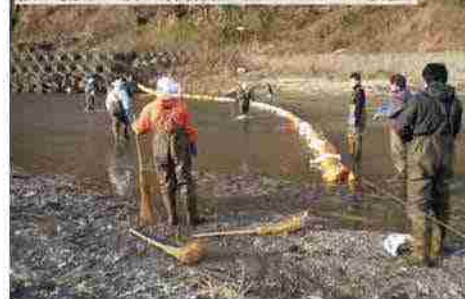
油の流下の防止作業(オイルフェンスの設置)
