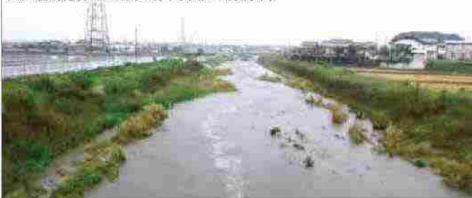
河川拡幅後(R2.6出水時)(寺沢川・前橋市)
