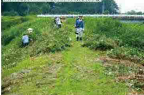
河川堤防における除草作業状況①
