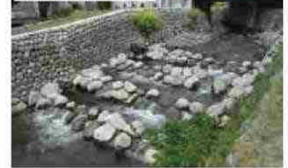
魚道(寺沢川・前橋市)
