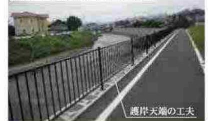
景観への配慮(井野川・高崎市)
