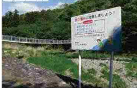
注意看板の設置
