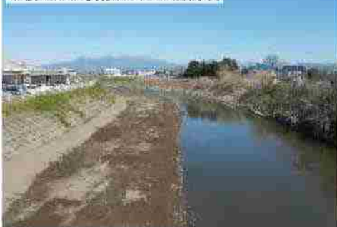
堆積土除去後(桃の木川・前橋市)
