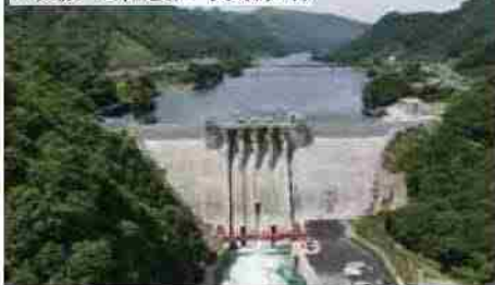
ハッ場ダム(吾妻川・長野原町)
