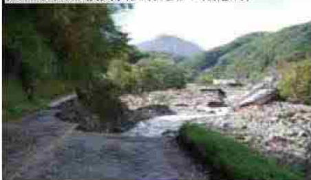
東日本台風 被災状況(吾妻川・嬭恋村)
