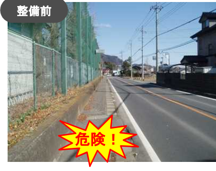
歩道が整備されておらず危険
