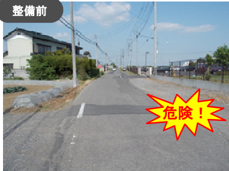
歩道が整備されておらず危険
