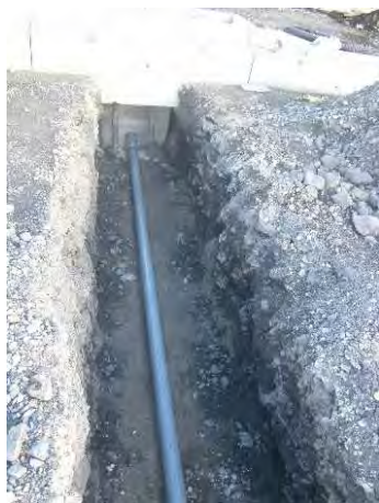
交差点部における信号管路整備
