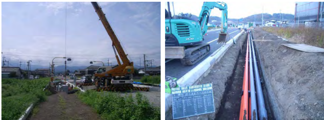
同時施工による無電柱化事業の実施状況
