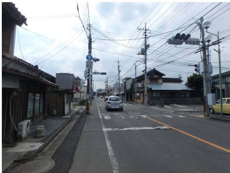
歩道内での地上機器設置が困難なため用地買収を進めている道路 (重要伝統的建造物群保存地区：桐生市桐生新町)
