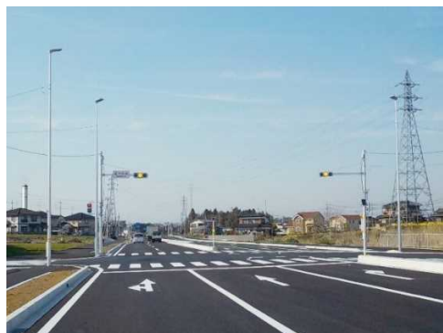
交差点部の上空横断線を無くした事例 国道122号
