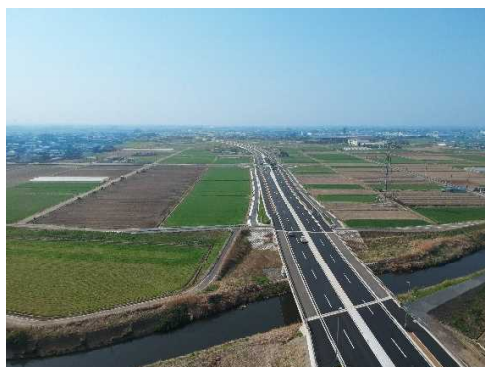
新設BPで電柱占用が無い状態 国道122号
