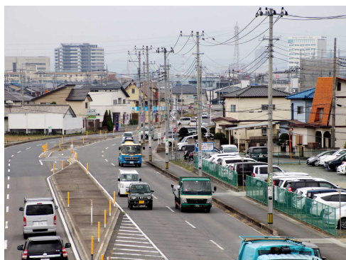
新設BPIにおける電柱占用状況 県道25号 高崎渋川線
