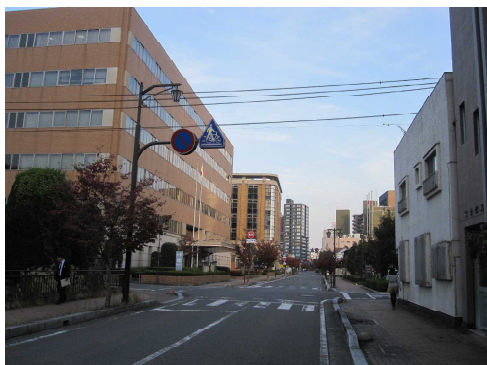
無電柱化された路線の交差点部 において横断線が残っている状況
