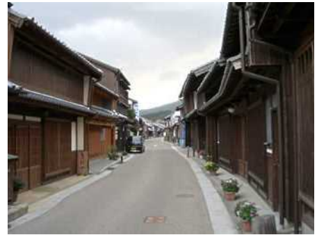
軒下配線方式の整備事例 <三重県亀山市関町> ※国土交通省 HP より
