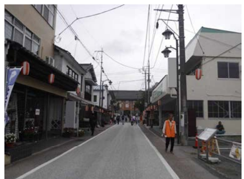
<景観を妨げる電柱状況> (富岡製糸場周辺)
