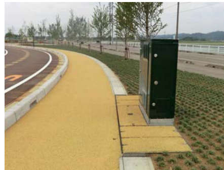
小型ボックス方式の整備事例 <見附市：ウエルネスタウンみつけ>
