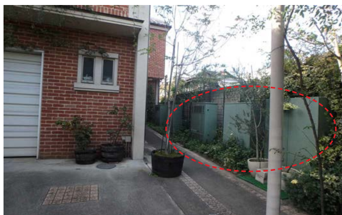
【道路区域外用地活用手法の整備事例(川越市)】
