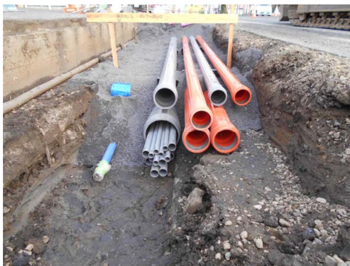
【電線共同溝の施工状況】
