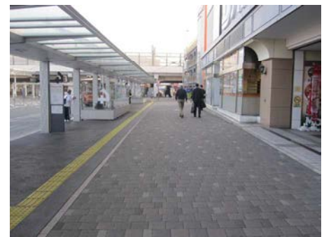
群馬県での整備事例 <前橋駅前広場>
