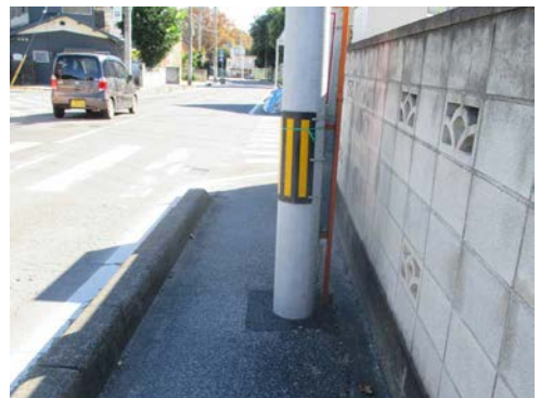
<通行を妨げる電柱状況> (ヤマダグリーンドーム周辺)
