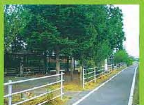
休憩施設 水飲み場、トイレ、公園、駐輪場、公衆電話、観水施設、駐車場
