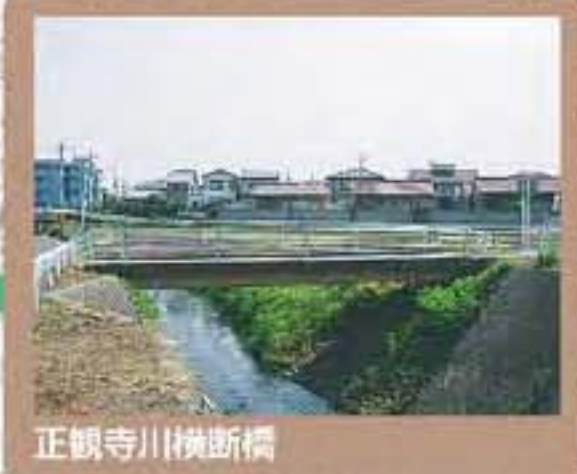
正統寺川横断橋
