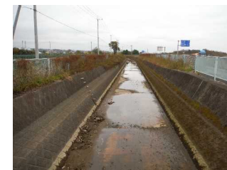
2 大正用水地区 (工事着手前)
