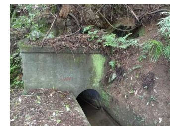
2 大間々用水地区 (工事着手前)
