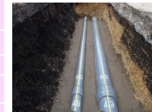
5 赤城原地区 （布設替工事中）
