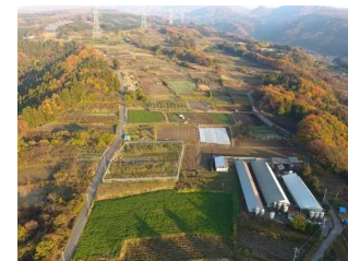
1 笠張地区 (工事着手前)
