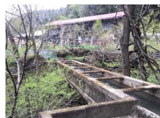
2 美野原2期地区 (工事着手前)
