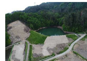
3 池田地区 （地震対策工事中）
