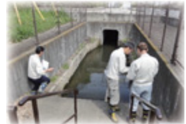
施設監視実施状況
