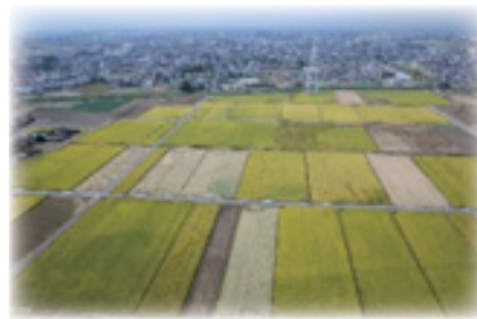
区画整理後・A工区 (太田市：世良田地区)
