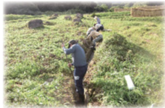
水路の土上げ(みなかみ町：師田地区)
