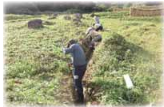
水路の土上げ(みなかみ町：師田地区)
