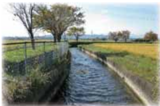
平安時代に開削されたと伝わる長野堰用水 (高崎市)
