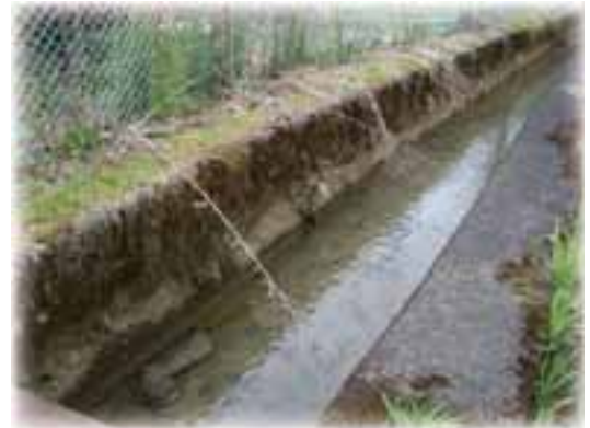
老朽化した農業水利施設(中之条町:美野原地区)
