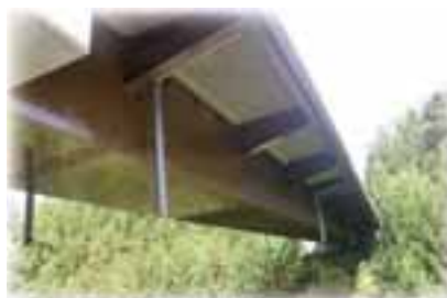
保全対策を実施した橋梁(農道) (渋川市：赤城南地区)
