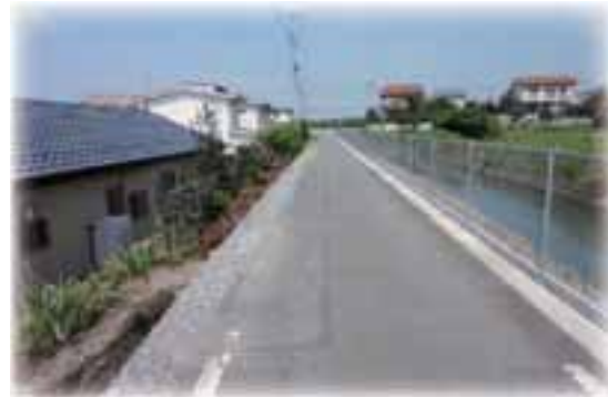
耐震性調査を行う農業水利施設（前橋市：大正用水地区）
