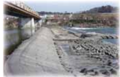
保全対策を実施する頭首工 (渋川市：坂東大堰地区)
