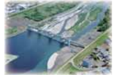
太田頭首工 (桐生市：渡良瀬川沿岸地区)
