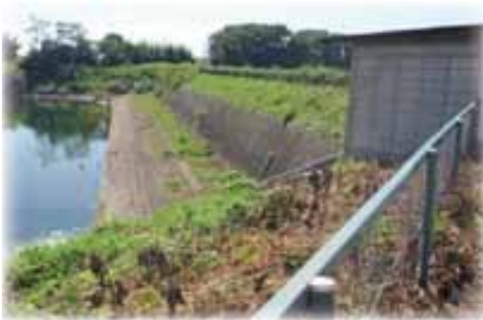
耐震性調査を行うため池（前橋市：乾谷地沼）
