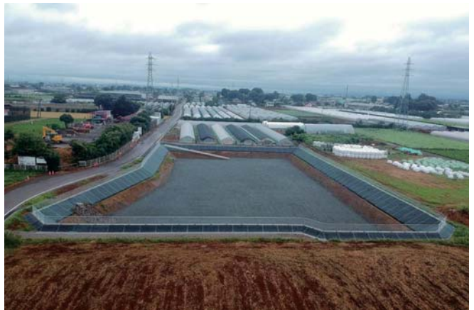
地域排水を貯留する調整池の整備状況
