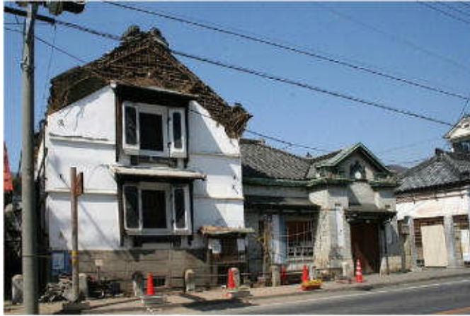
桐生市内の国登録有形文化財（建造物）の被災状況
