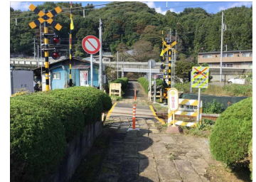
【踏切遮断機の整備】
