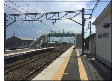
【ホームの点状ブロック整備】
