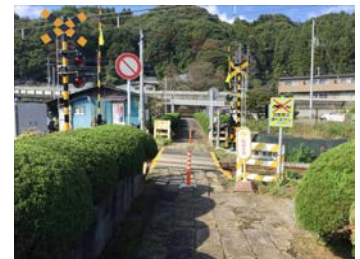
【踏切遮断機の整備】
