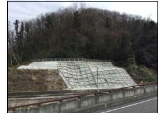
【切土による土砂災害対策】
