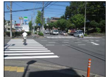
【緊急安全点検に基づく対策】
