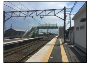
【ホームの点状ブロック整備】
