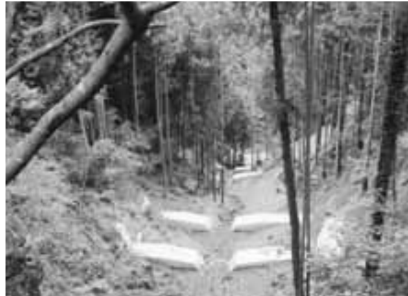
山地逕流を保全する治山ダム工
