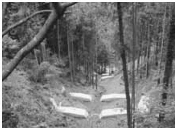
山地溪流を保全する治山ダム工
