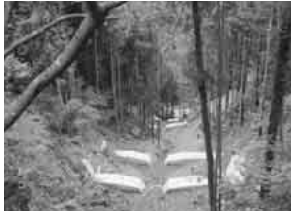
山地溪流を保全する治山ダム工
