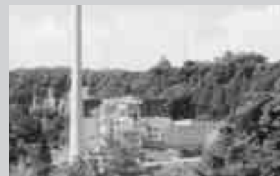
【吾妻木質バイオマス発電所】
