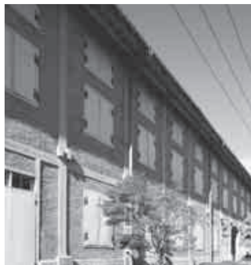
南側から見た東蕪倉庫(木骨煉瓦造)
