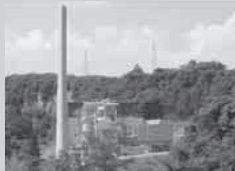
吾妻木質バイオマス発電所
