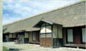
3 旧安中藩郡奉行役宅・武家長屋
