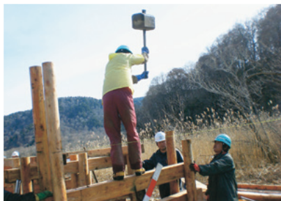
③ 木道工事は手作業で行う
