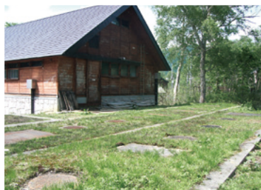
△ 公衆トイレ裏の合併処理浄化槽
