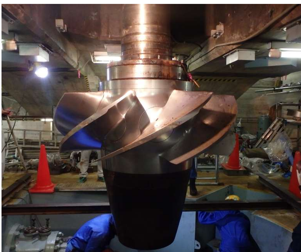
利南発電所 吊り込み中のランナ
