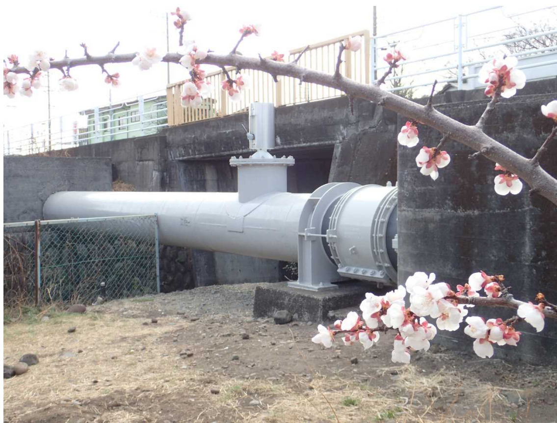
澁川工業用水道事務所 金沢川水管橋
