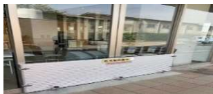
（止水板の設置）
