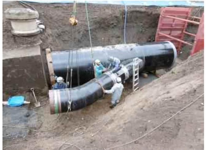
送水管（異形管） 内径：900 mm
