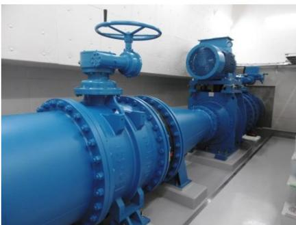
水力発電は、流水エネルギーにより水車を回転させ、その回転を発電機に伝え、発電する仕組みです。したがって、落差が大きいほど、流量が多いほど、発電量は大きくなります。
