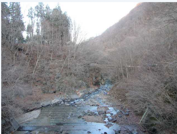
③堰堤下流側
