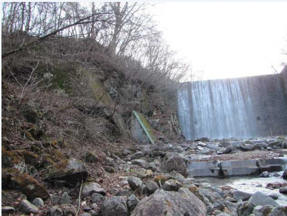
②堰堤正面
