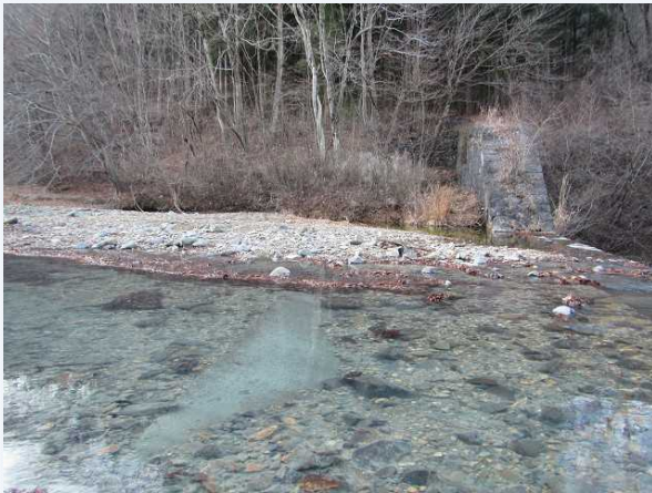
①堰堤上流側
