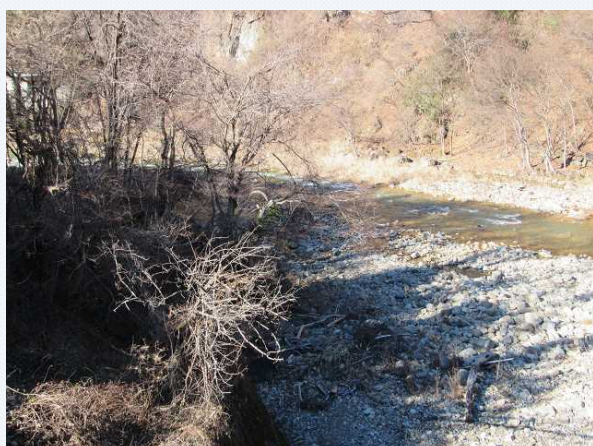
③堰堤下流側
