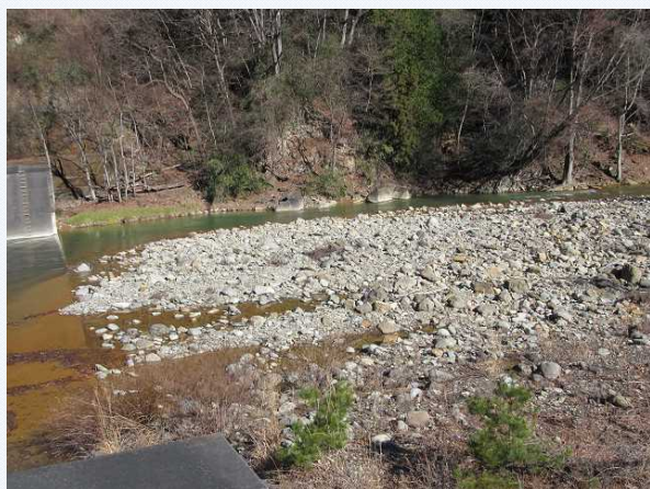
①堰堤上流側
