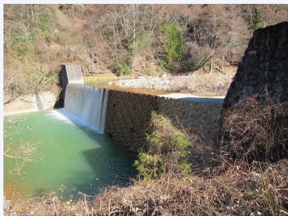
②堰堤正面
