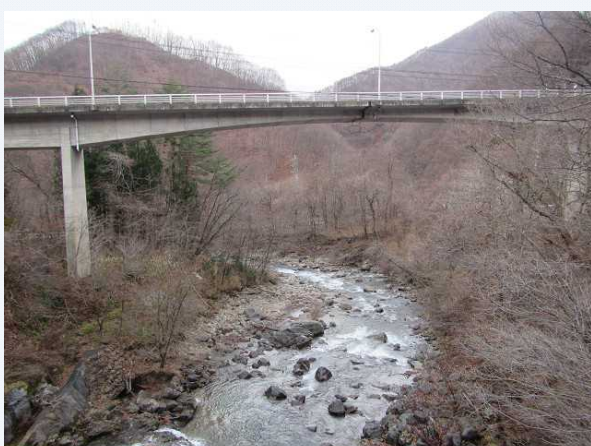
③堰堤下流側
