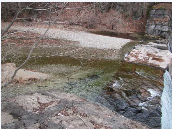
①堰堤上流側
