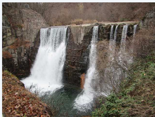
②堰堤正面
