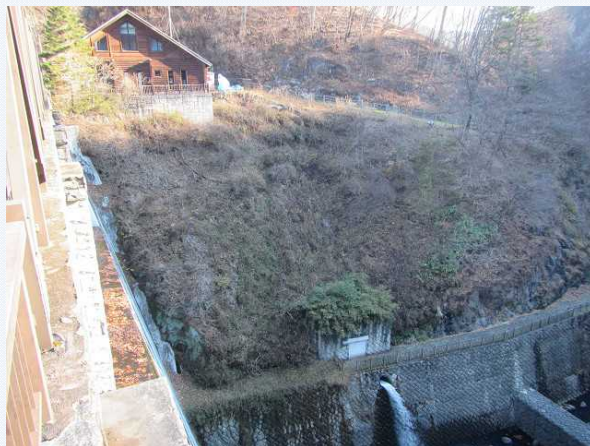
⑤既設取水施設
