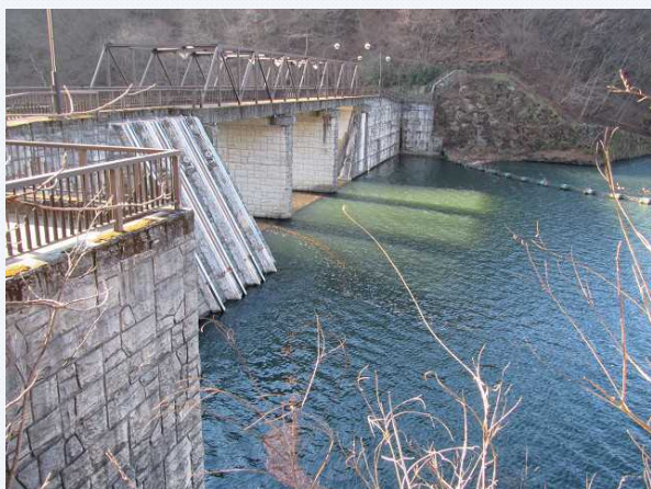
①ダム上流側
