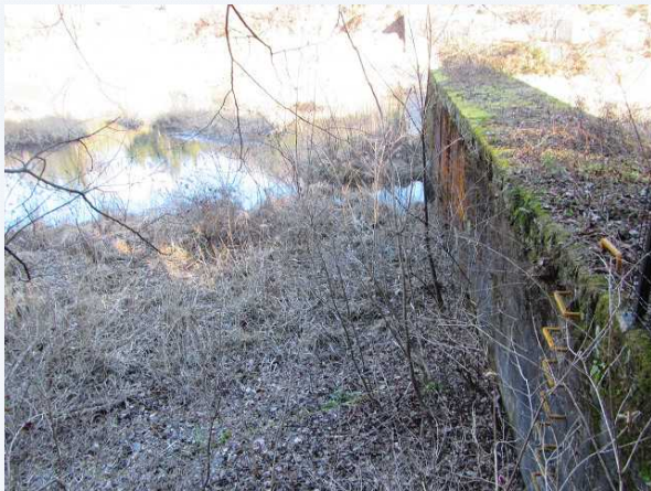
①堰堤上流側
