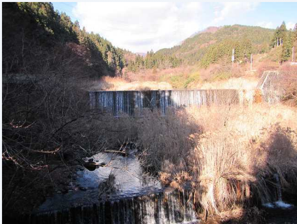
②堰堤正面
