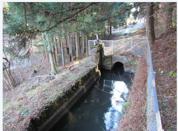
⑥既設取水施設 (上流側から望む)
