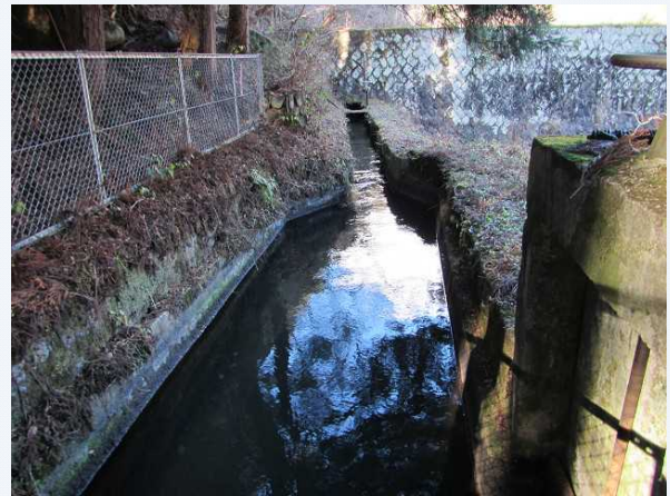
⑤既設取水施設 (下流側から望む)
