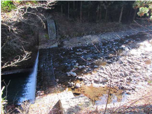
①堰堤上流側
