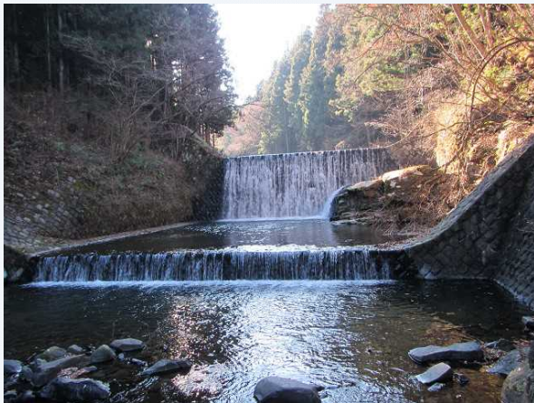
②堰堤正面
