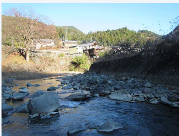
③堰堤下流側
