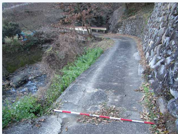
⑤周辺の既設道路
