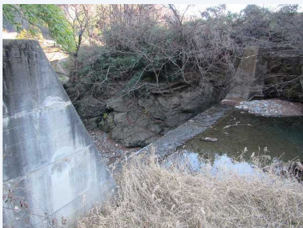
①堰堤上流側
