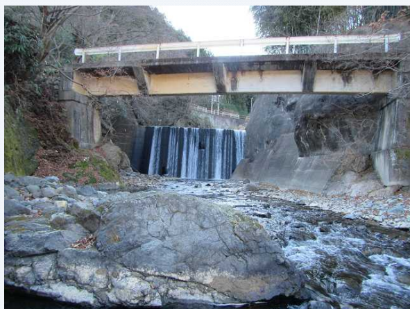
②堰堤正面
