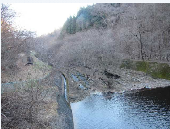
③堰堤下流側
