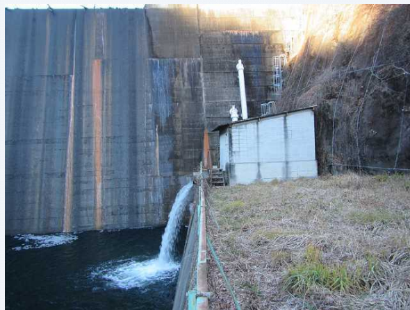
⑤既設水道取水施設
