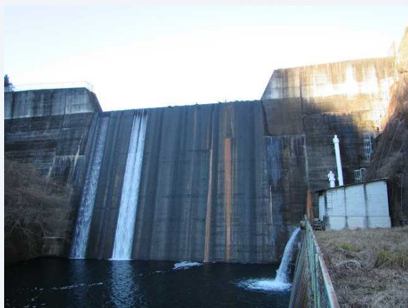
②堰堤正面
