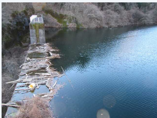
①堰堤上流側
