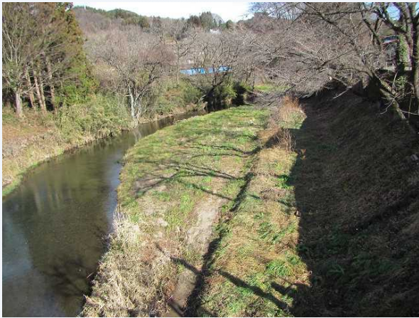
①堰堤上流側
