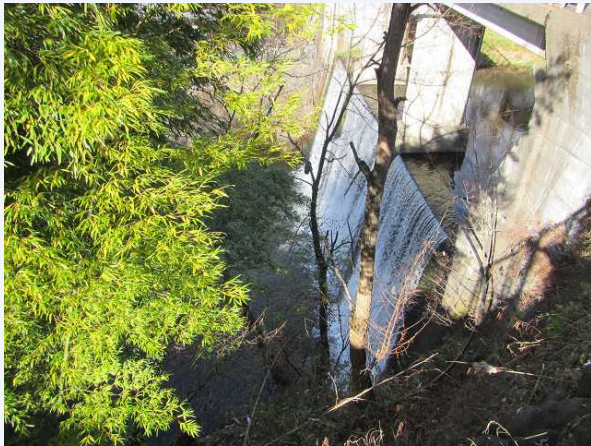
②堰堤正面
