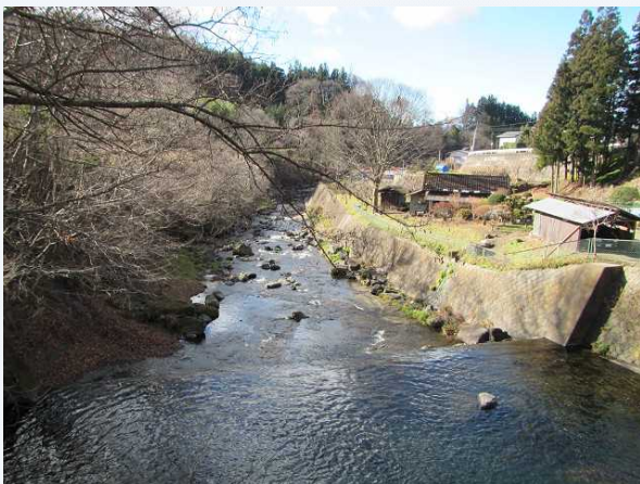
③堰堤下流側
