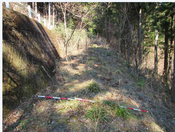
⑤既設管理用道路
