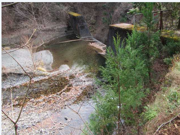
①堰堤上流側
