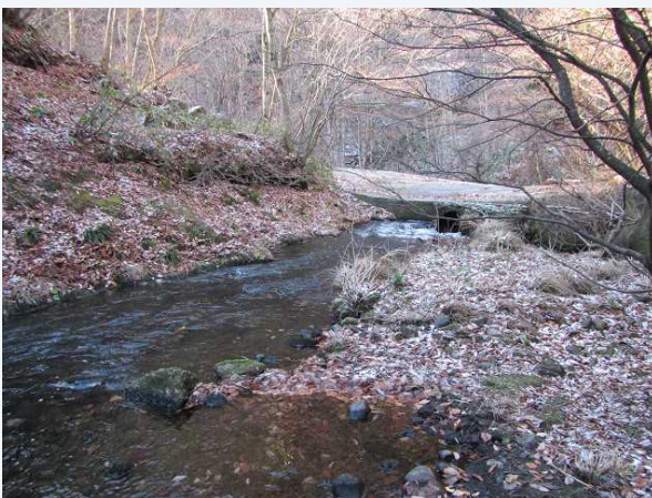
③ 堰堤下流側
