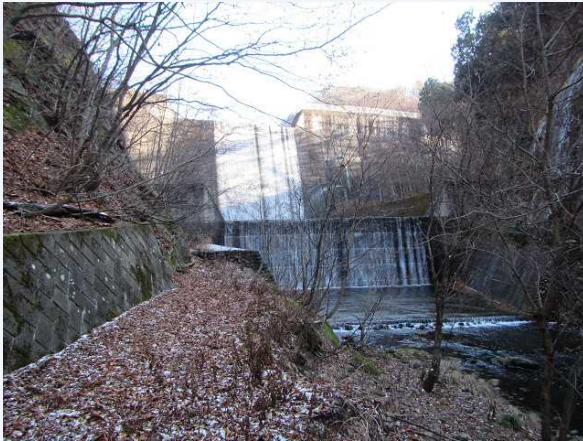
② 堰堤正面
