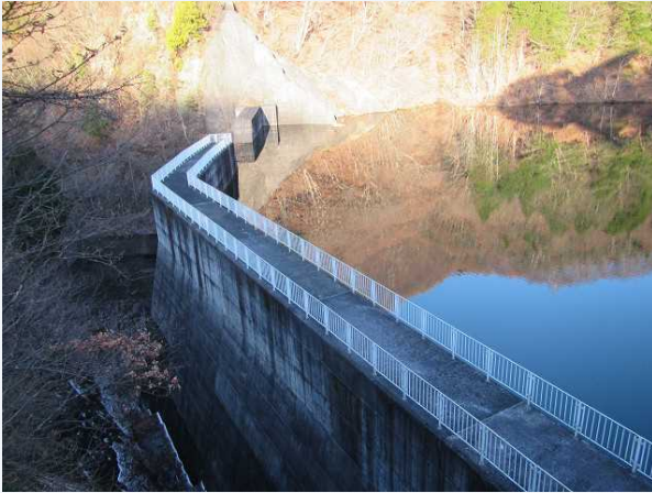
① 堰堤上流側
